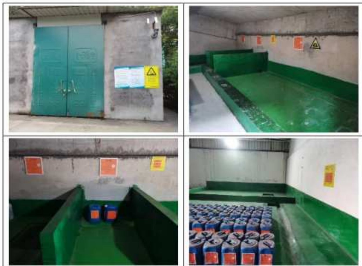
图3.1-4 现有危废暂存间
