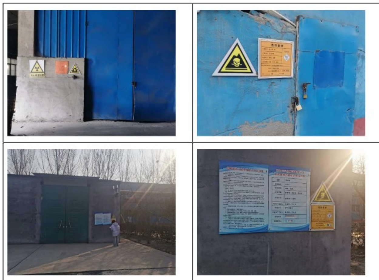
图3.1-4 现有危废暂存间
