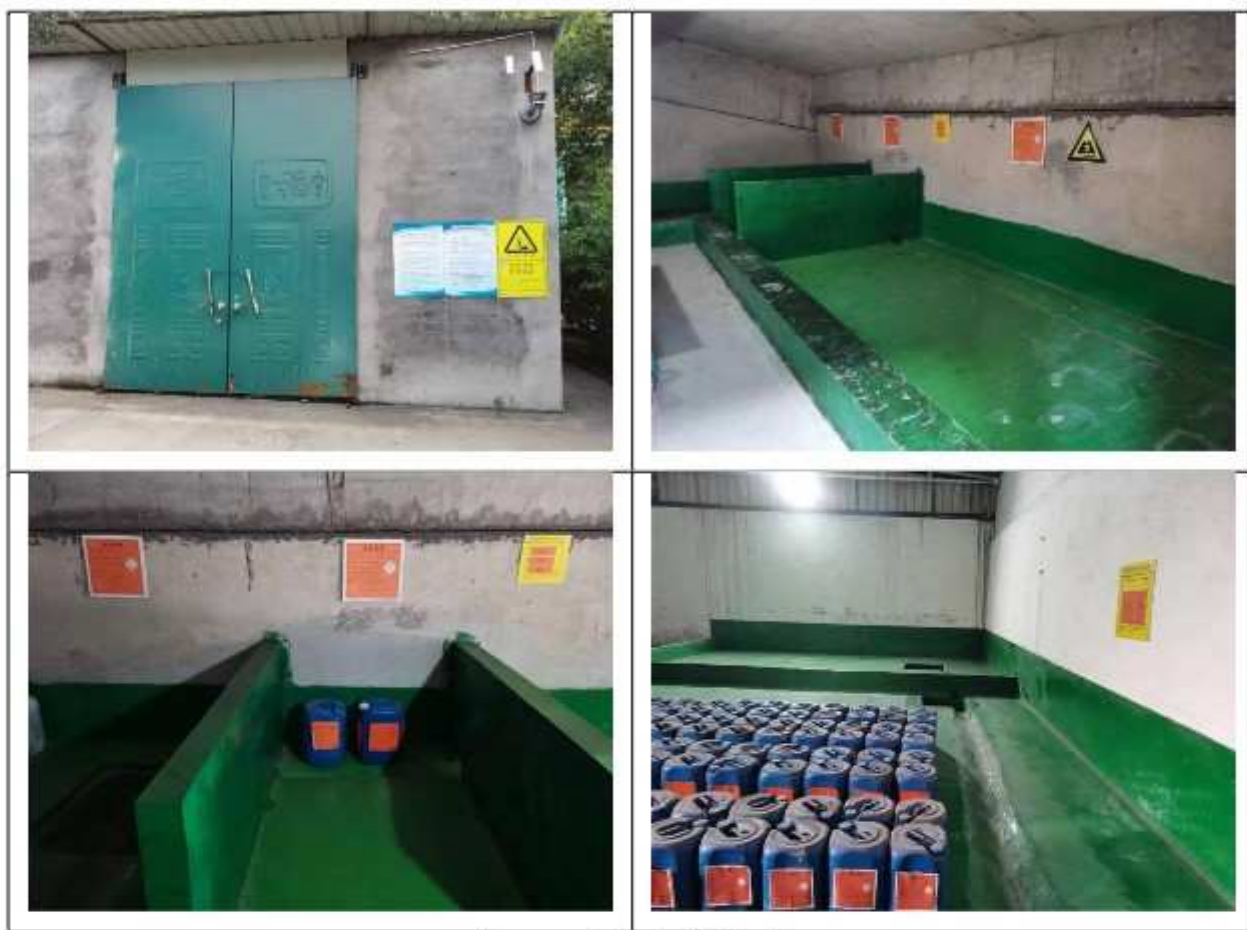
图3.1-4 现有危废暂存间
